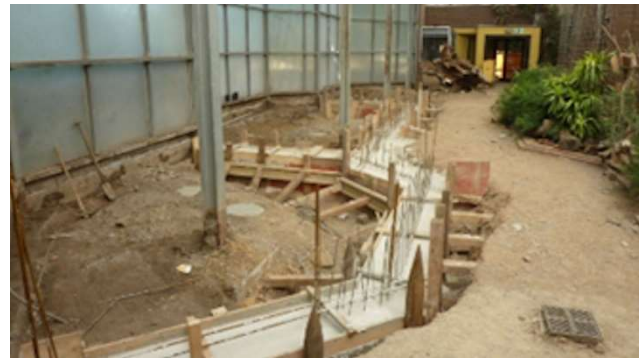
Die Fundamente wurden im August 2021 gegossen.
